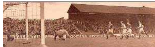
1957, Red Star – Bordeaux, en D 2 (1-2) ... une partie d'une tribune du stade, sans toiture
